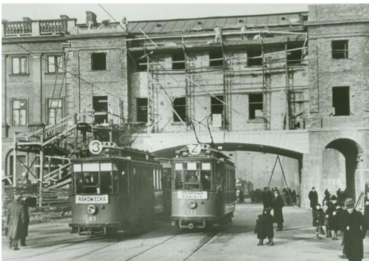
Rys. 3.1. Widok z pl. Krasieńskich na przebitą przejazd pod Gmachem Sądu Najwyższego
